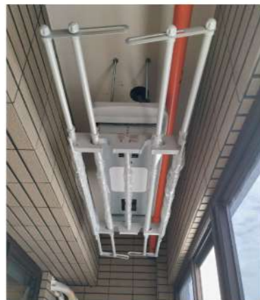
◦ 陽台安裝實例
